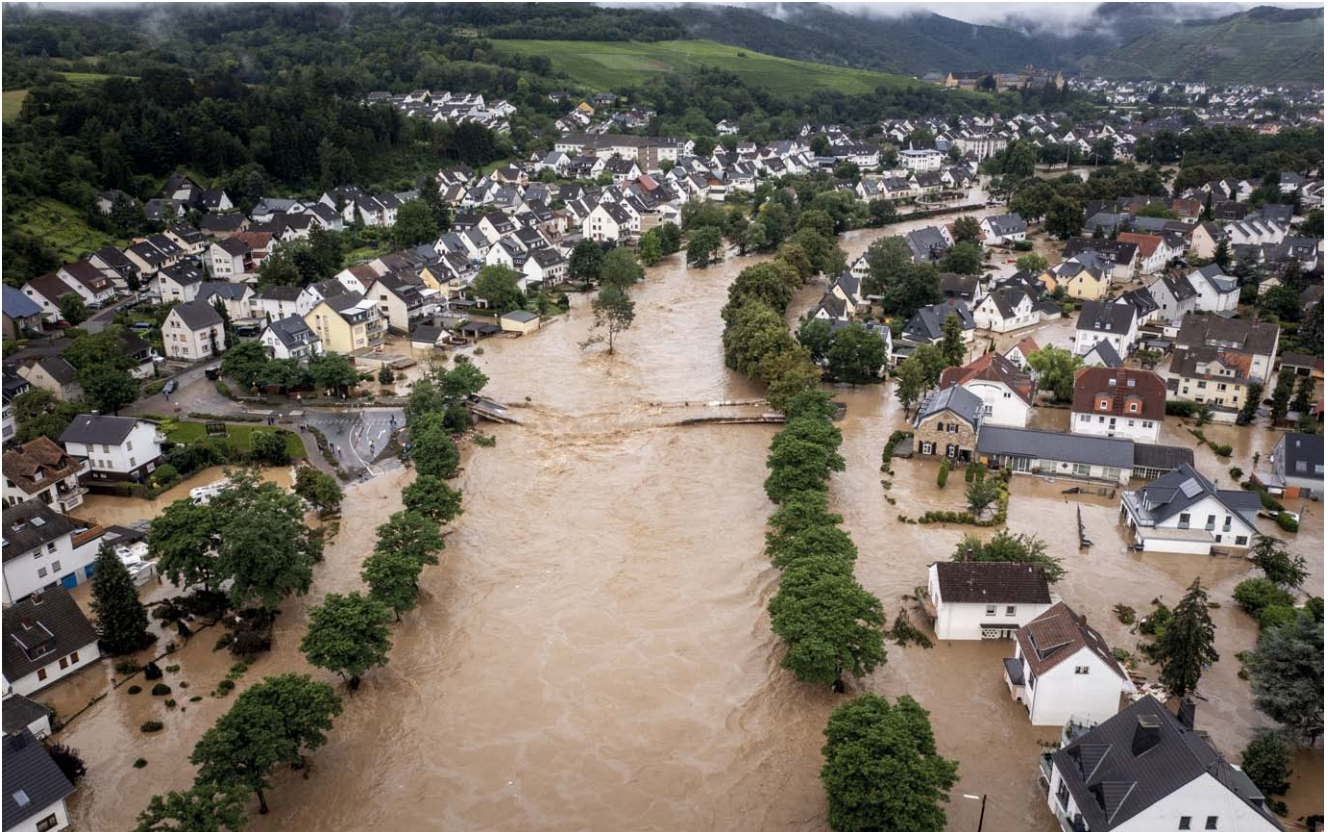
Verletzliche Infrastrukturen: Die Katastrophe im Ahrtal hat gezeigt, wie verwundbar unsere Infrastrukturen sind.
