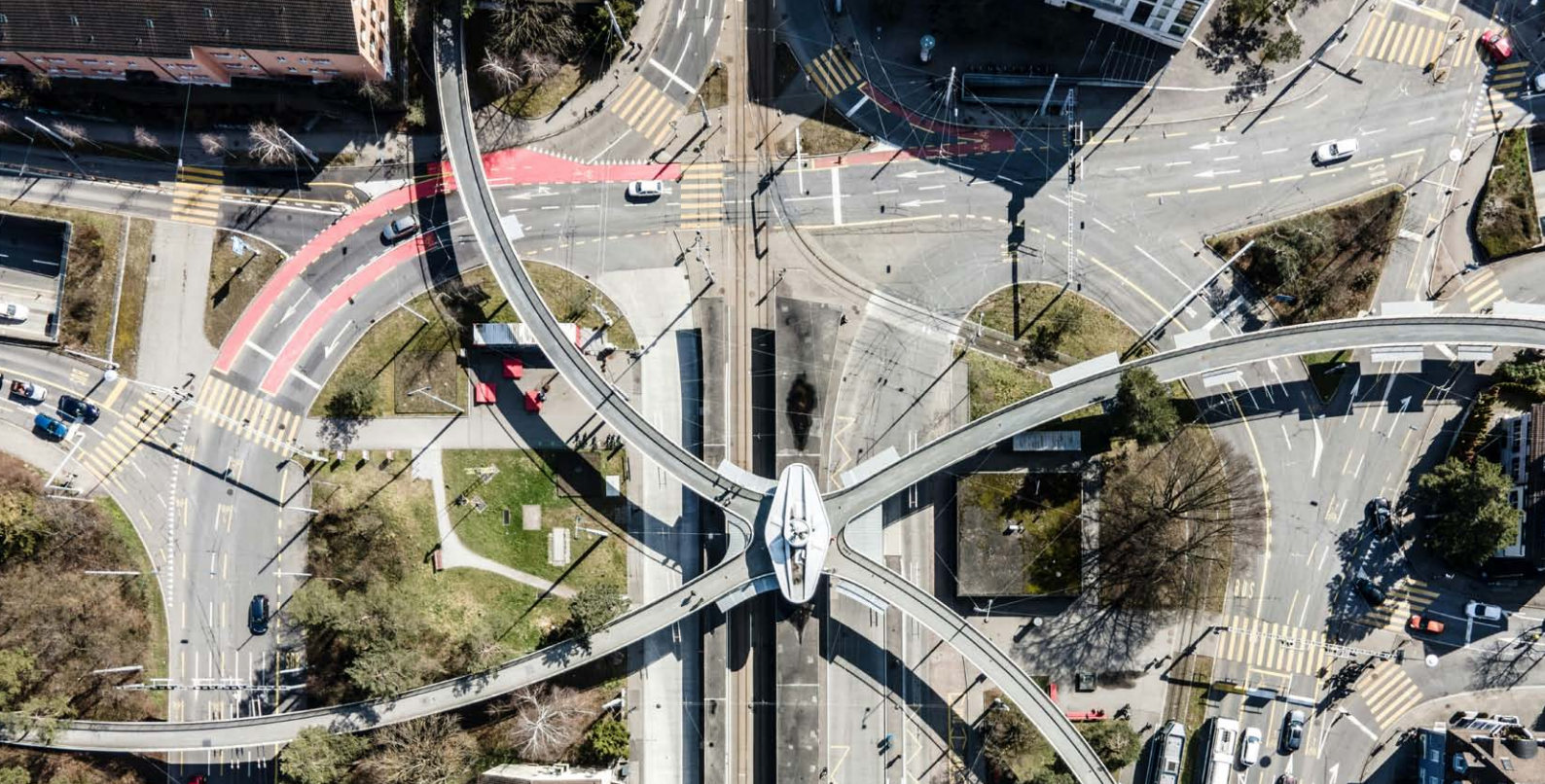
Zunehmende Komplexität: Das Fraunhofer EMI entwickelt Konzepte, um den Verkehr der Zukunft sicher und ressourceneffizient zu gestalten. Luftbild vom Bucheggplatz in Zürich.
